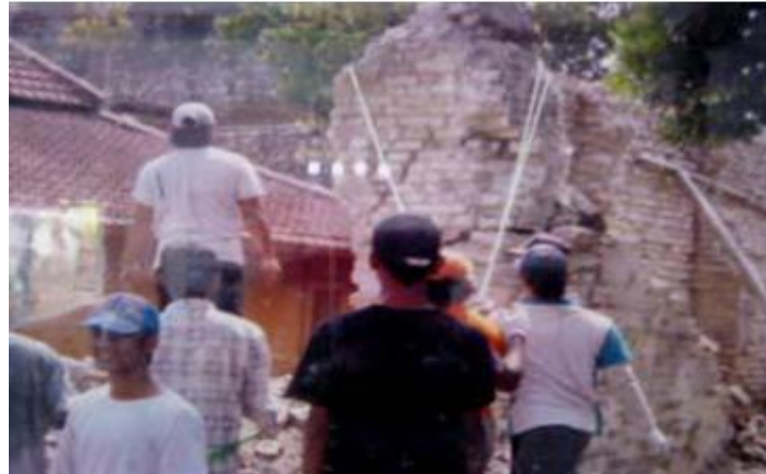
Gambar 5: Pembongkaran pagar bangunan yang rusak.
